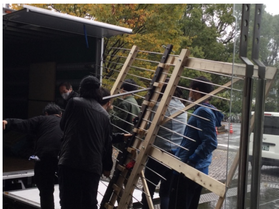
解体した音響彫刻の搬出
